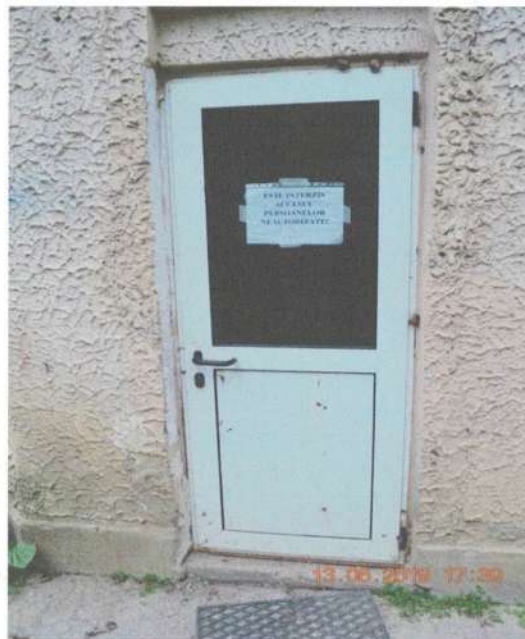
Ușă parter centrală termică latura Vest
