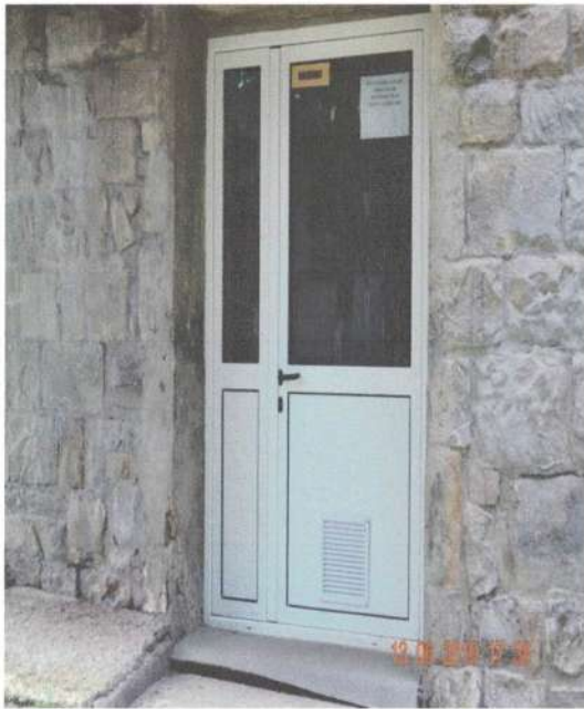
Ușă demisol bucătărie latura Sud
