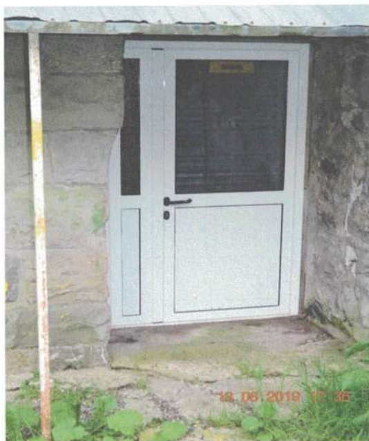
Ușă magazie demisol latură Nord
